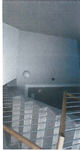
Billede: Eksisterende trappeopgang og kælderder
