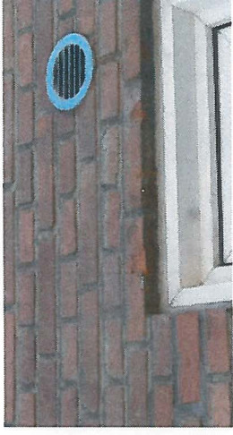
Billede: Eksisterende naturligt aftræk gennem facaden fra badeværelset
